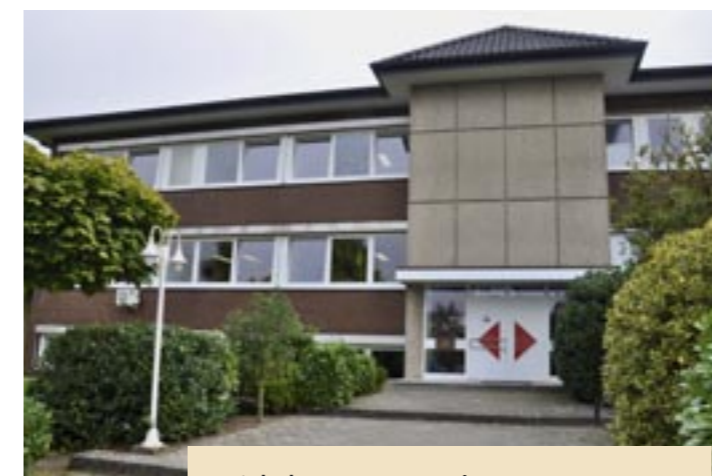
Viel Platz: Neue, moderne Büroräume im alten Tuitjer-Gebäude Mettingen bieten jetzt genügend Raum für zukünftige Aufgaben.
