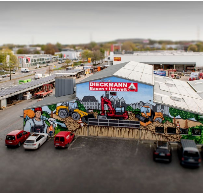
Das neue Energiemanagement erfasst systematisch alle Energiequellen, Energieeinsätze und die Energieverbraucher. Ziel ist neben einer Kostensenkung einen positiven Beitrag zum Klima- und Umweltschutz zu leisten wie z. B. mit unserer Photovoltaikanlage.
